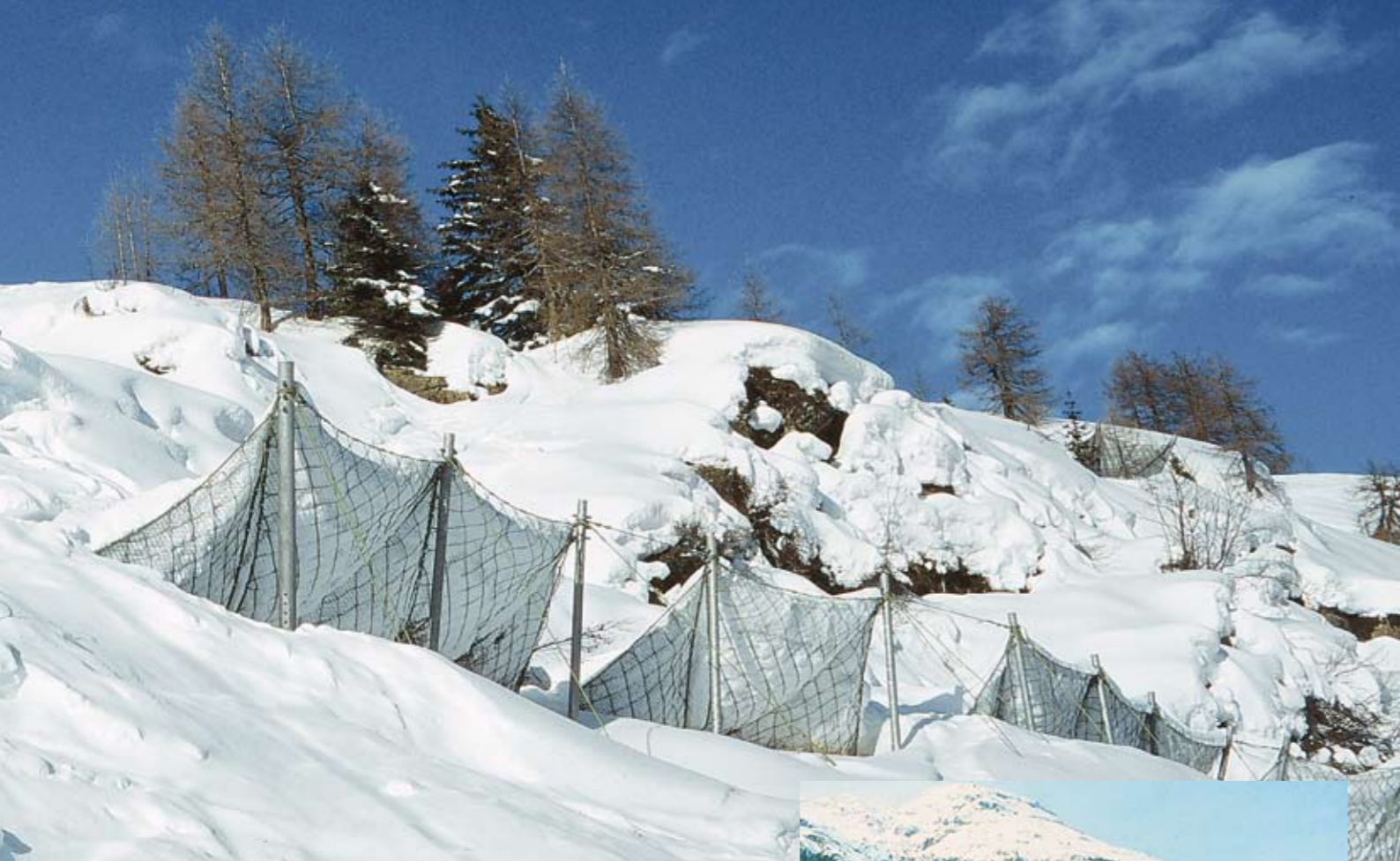
Sopra: reti metalliche.
